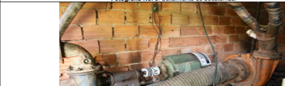
Fotografía No. 7. Imposición de sellamiento de bocatomas.
